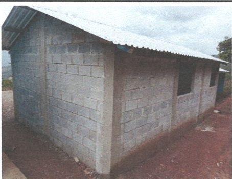
Foto 4: Mejoramiento de aula
