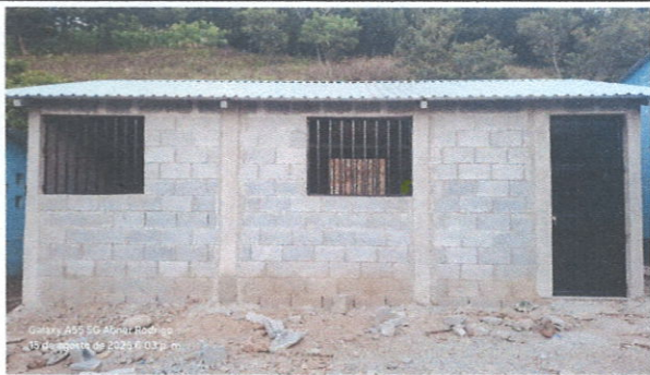
Foto 5: mejoramiento del cerco perimetral
