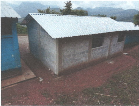
Foto1: Mejoramiento de aula
