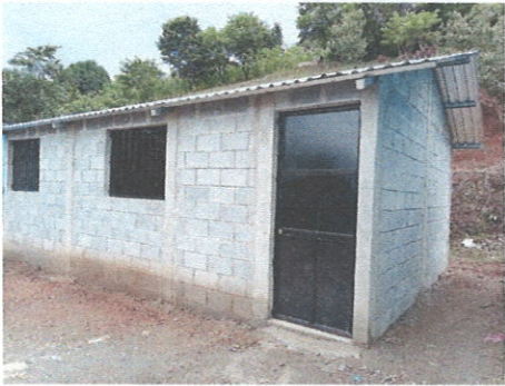
Foto 2: Mejoramiento de aula
